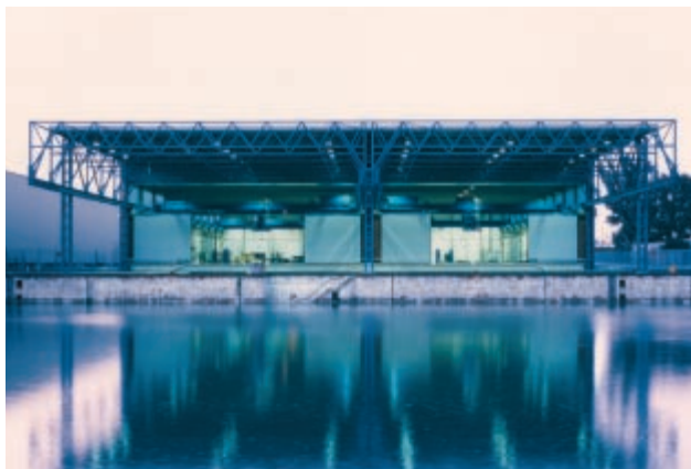
SCHMOLZ+BICKENBACH, Wien (Hafenseite) SCHMOLZ+BICKENBACH, Vienna (Harboursite)
