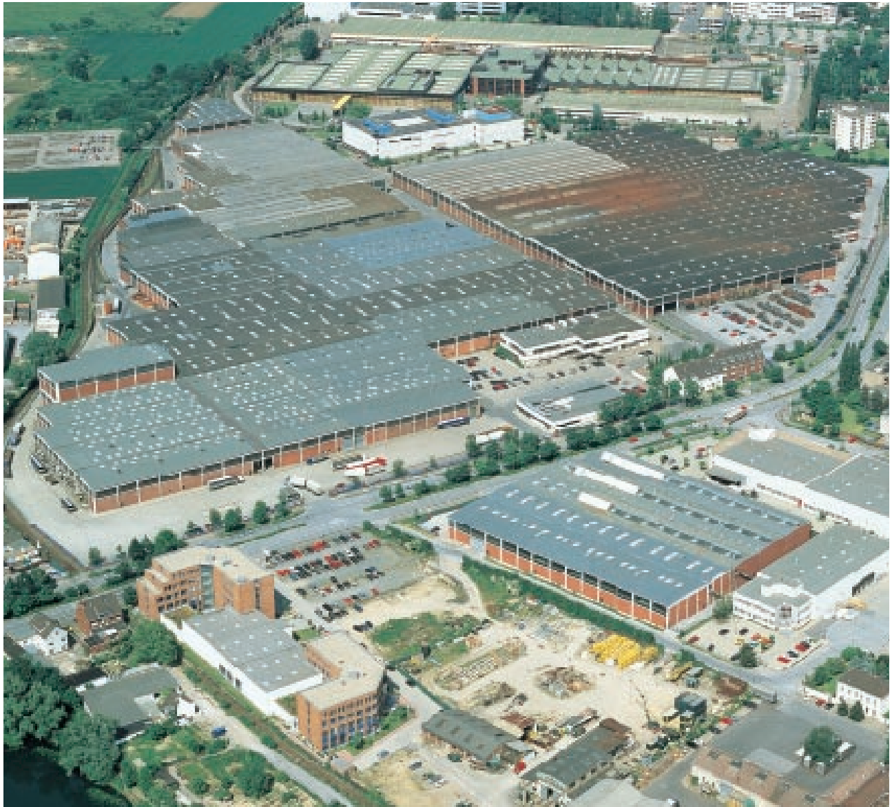
SCHMOLZ+BICKENBACH Produktions- und Lagerhallen in Düsseldorf Production and storing facilities in Düsseldorf
