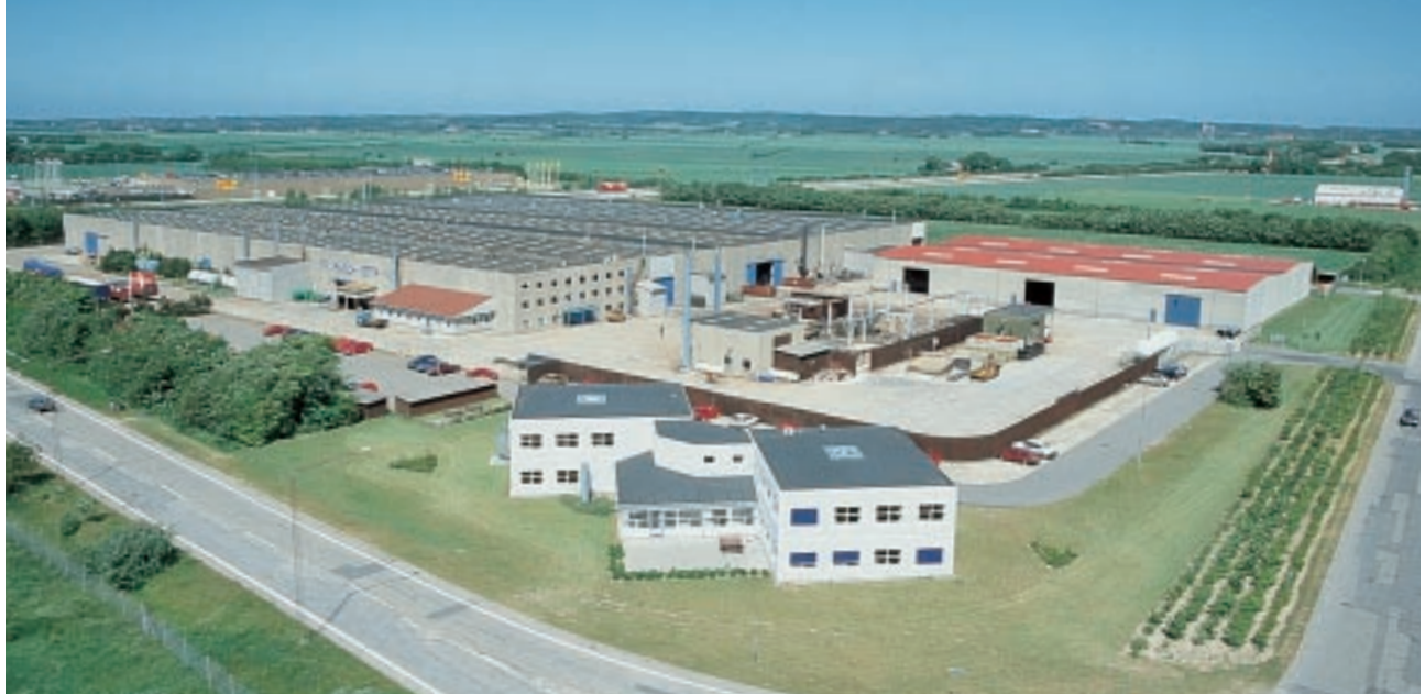
SCHMOLZ+BICKENBACH Produktions- und Lagerhallen in Nørresundby, Dänemark (vormals Fr. Rasch's Estf.) Production and storing facilities in Nørresundby, Danmark (previous Fr. Rasch's Estf.)
